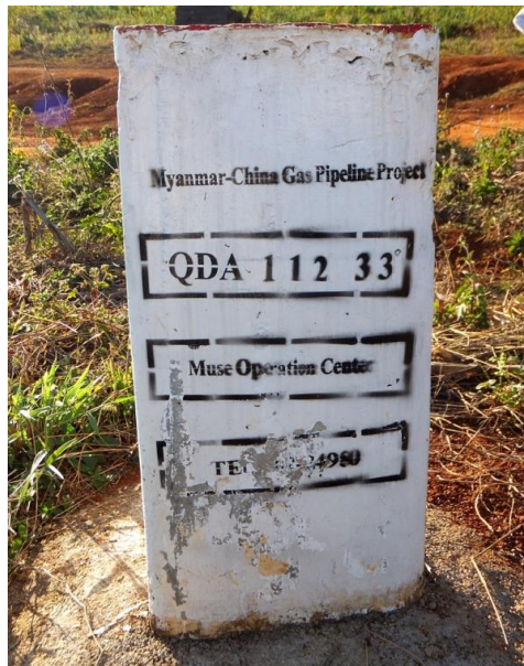
パイプライン標識（ラショー付近）
