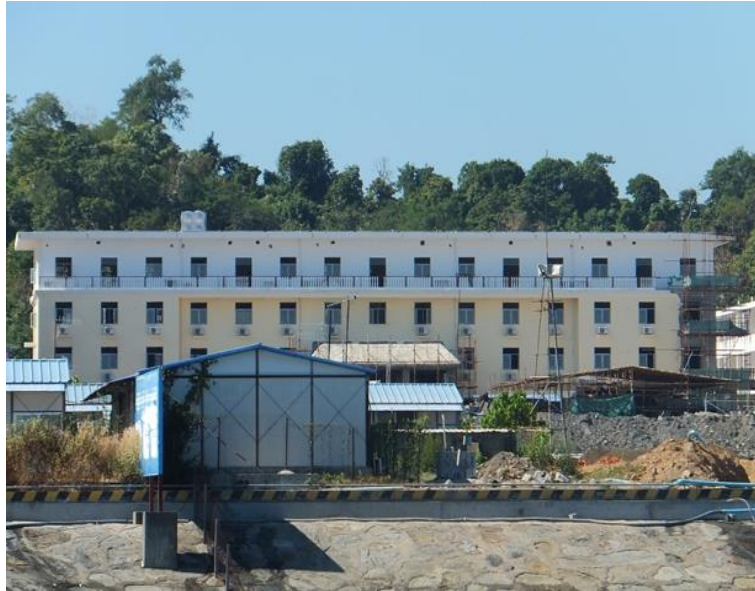
中国人用宿舎（マデー島。建設中）
